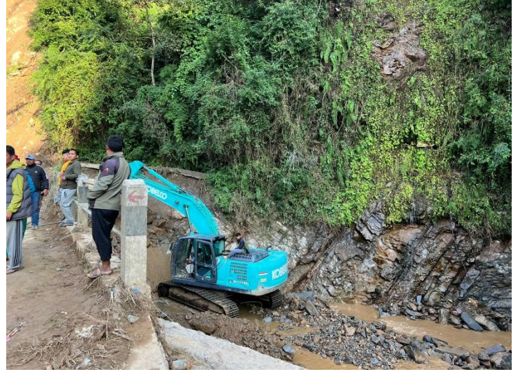
महालक्ष्मी खोलामा पुल भत्किएपछि डोजर लगाएर बाटो खोल्दै गर्दाको दृश्य
